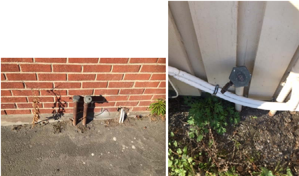
Figur 9. Bilder fra befaring av gamle fyllingsrør til olje. Til venstre: ved gammel industribygning ved på tidligere område til Årnes fabrikk. Til høyre: Esso påfyllingsrør tilhørende Nes bo- og servicesenter.
