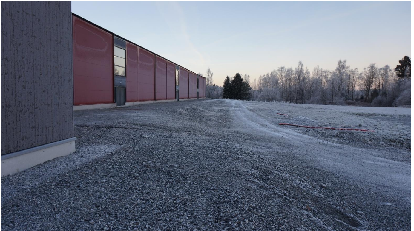
Bilde 1. Oversikt over nordøstre fasade på Nes Arena, og areal der tilbygget skal bygges.
